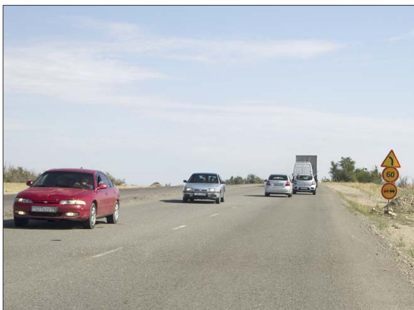
Перед населенным пунктом Кызылагаш идет строительство дороги
