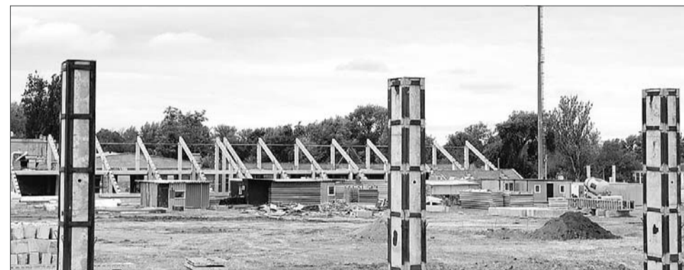
На стадионе начали дренаж поля, армирование здания и утепление фасада трибун.
