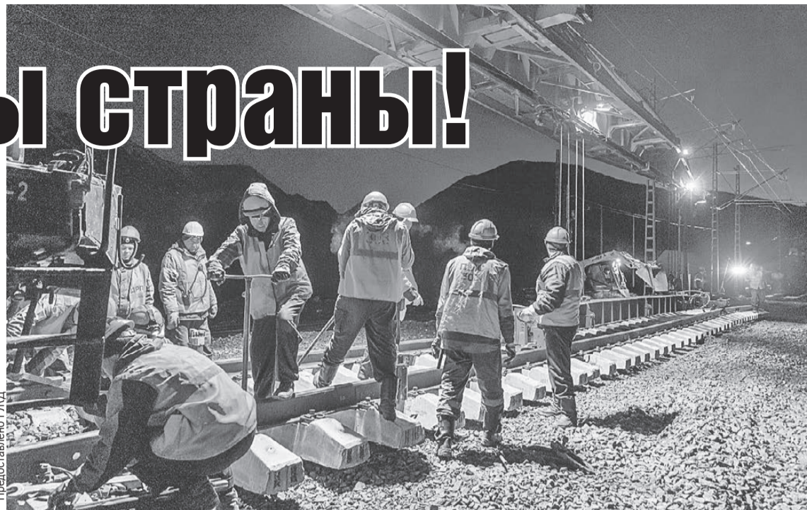
За последние 10 лет уложено 3 тысячи километров магистральной. Впереди - новый этап модернизации, и это еще около 3 тысяч км.
