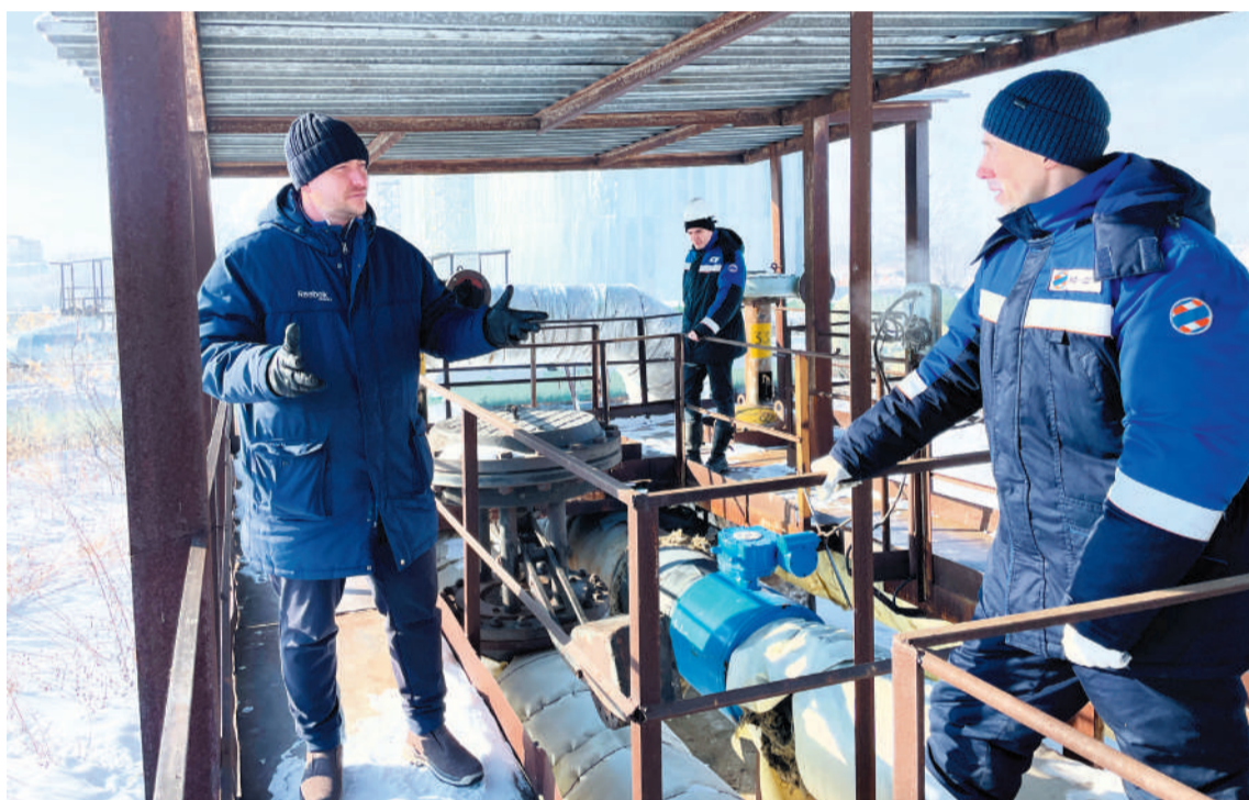
Подготовка к строительству началась задолго до теплого времени года.
