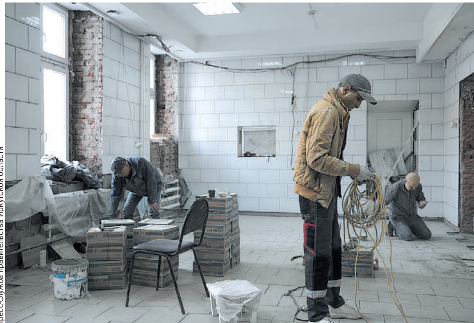
Помещение для новых аппаратов гемодиализа уже ремонтируется.
