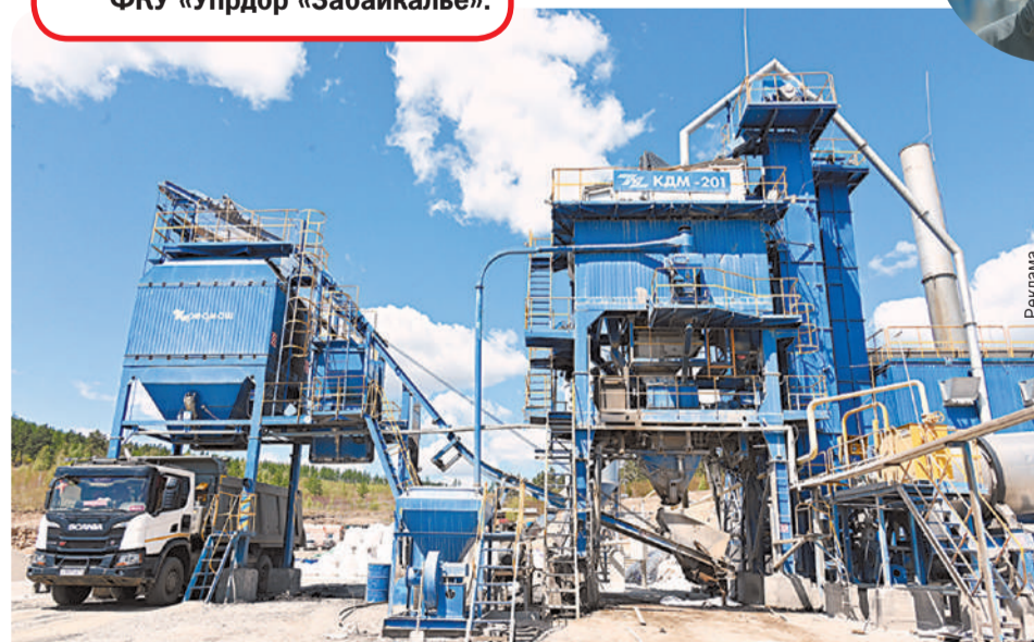
Асфальтобетонный завод, работающий на газовом топливе.
