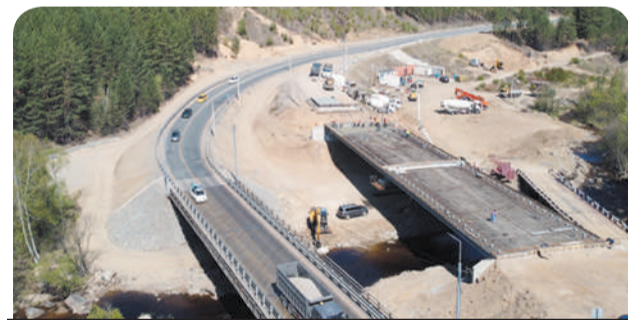
Обновляется мост через реку Никишиху на 15 км автодороги А-350 Чита - Забайкальск.
