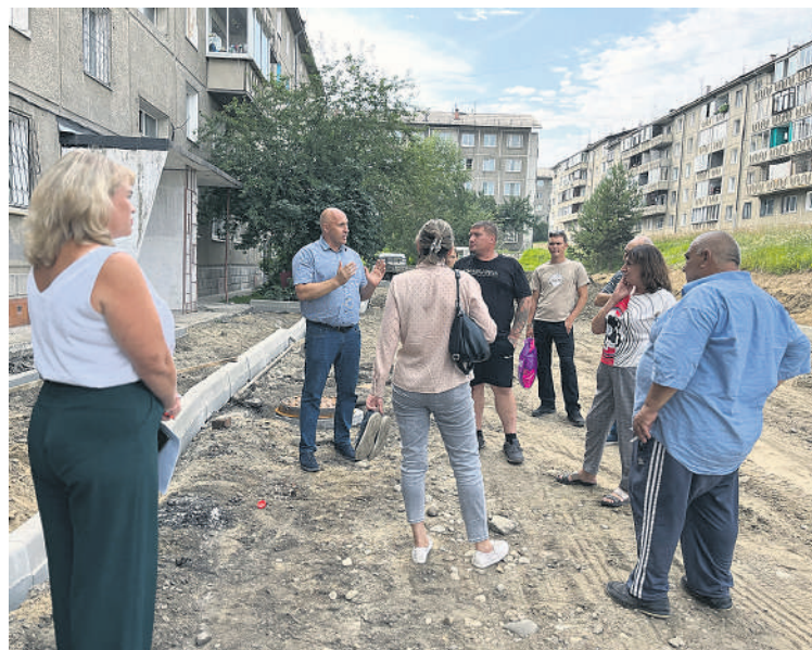
Работы по благоустройству дворов обсуждаются с местными жителями.
