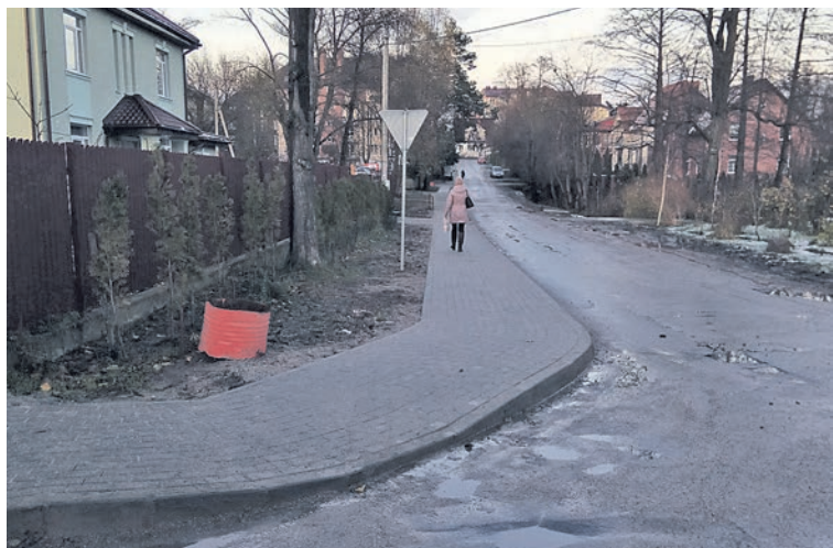
А это - отремонтированный тротуар в Прудовом переулке.
