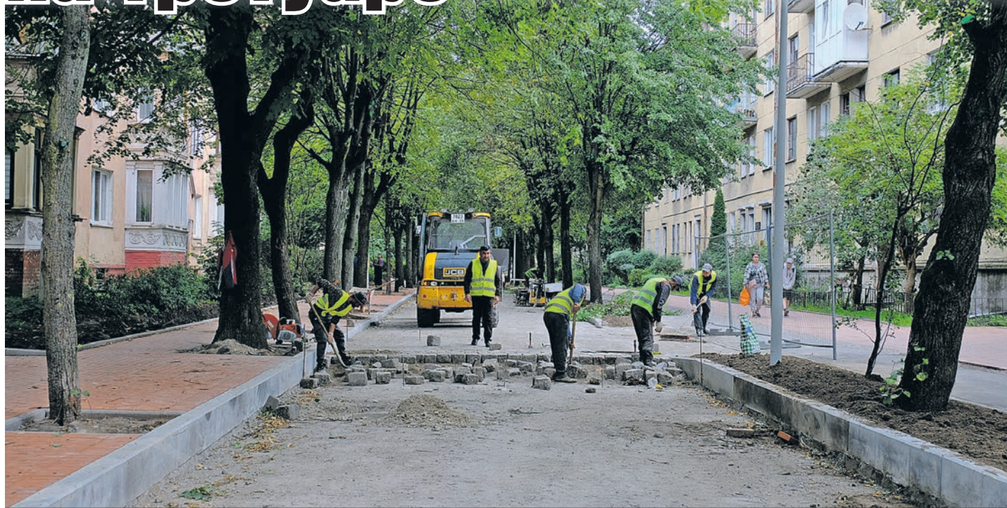
На улице Красной работа кипит. Объект должны сдать в январе 2024 года.
