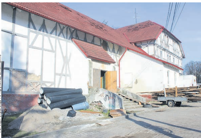
Здание Дома культуры является объектом культурного наследия местного значения.
