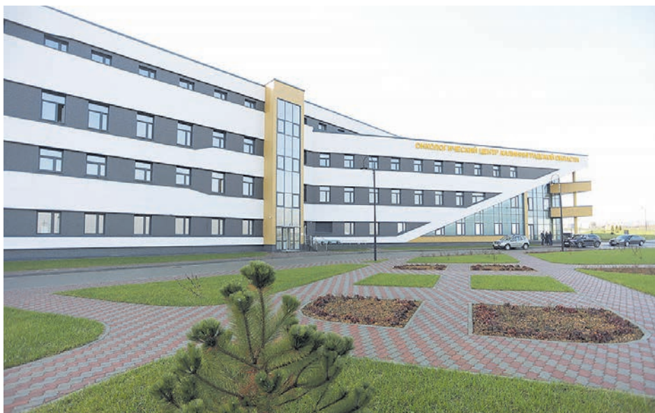
Общая стоимость строительства объекта составила более 8 миллиардов рублей. Техническая готовность онкоцентра - 100 процентов, в январе его ввели в эксплуатацию.
