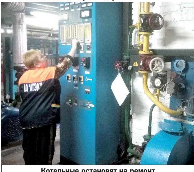
Котельные остановят на ремонт.
