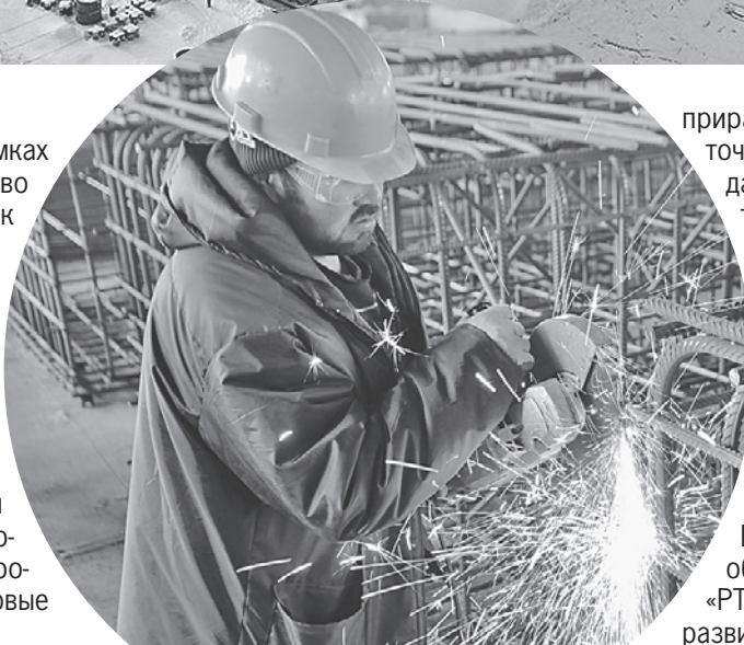
Монтаж оборудования на высокотехнологичном предприятии - дело тонкое.
