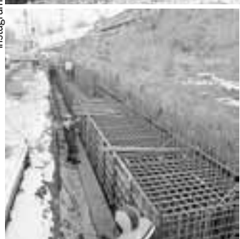
Работы на Трофимовском мосту ведутся круглосуточно.
