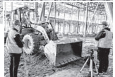
ООО «РСК» готово проявить себя и в промышленно-гражданском строительстве.
