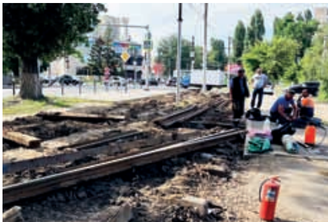
За демонтажем путей - укладка нового полотна.
