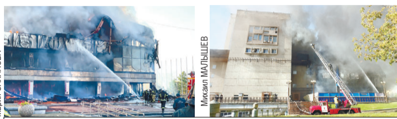
Сначала загорелась крыша, а после огонь охватил все здание.
