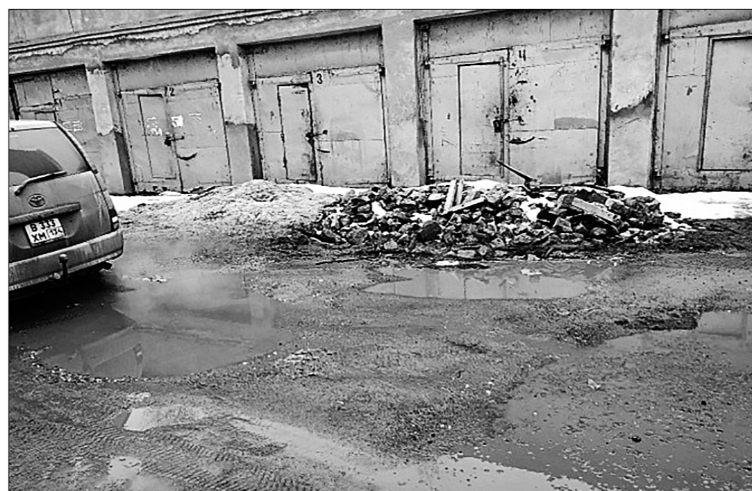
□ Местные жители уже смирились с огромными ямами на дороге.
