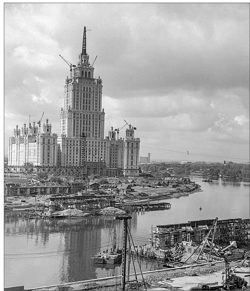
Строится гостиница «Украина» в окружении деревянных домиков Дорогомисловской слободы.
