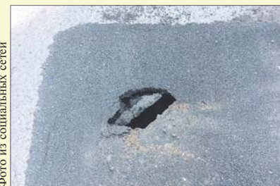
На месте провала мог находиться коллектор, который дорожники во время ремонта закатали в асфальт.
