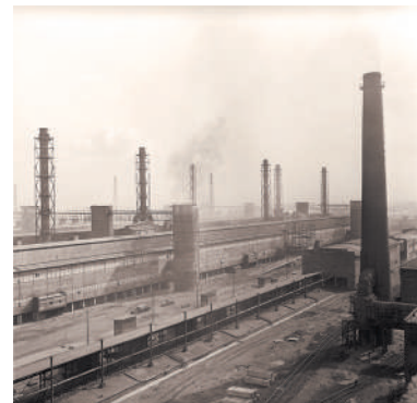
Начало 1970-х: ударная комсомольская стройка — Красноярский алюминиевый завод.
