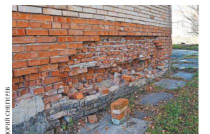
Больше всего опасений вызывает фундамент. Дожди вымыли цемент, и кирпичи вываливаются наружу.
