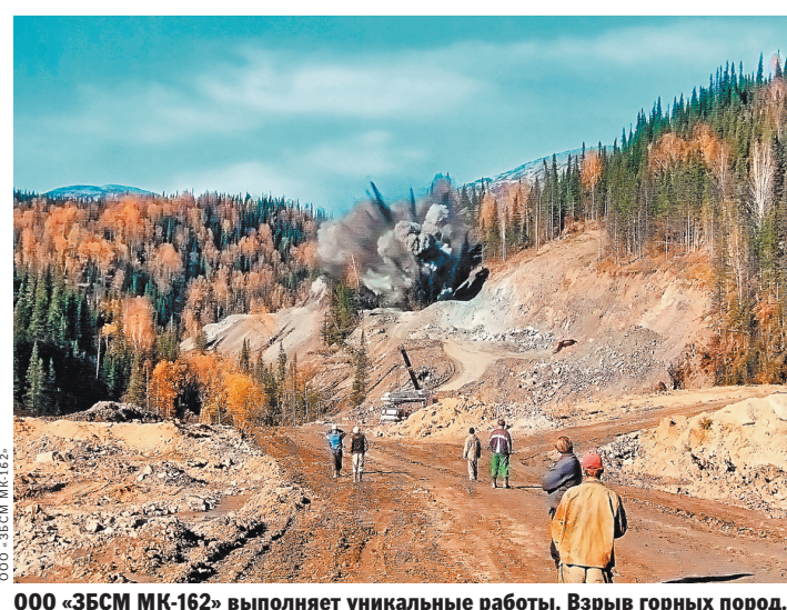
ООО «ЗБСМ МК-162» выполняет уникальные работы. Взрыв горных пород.
