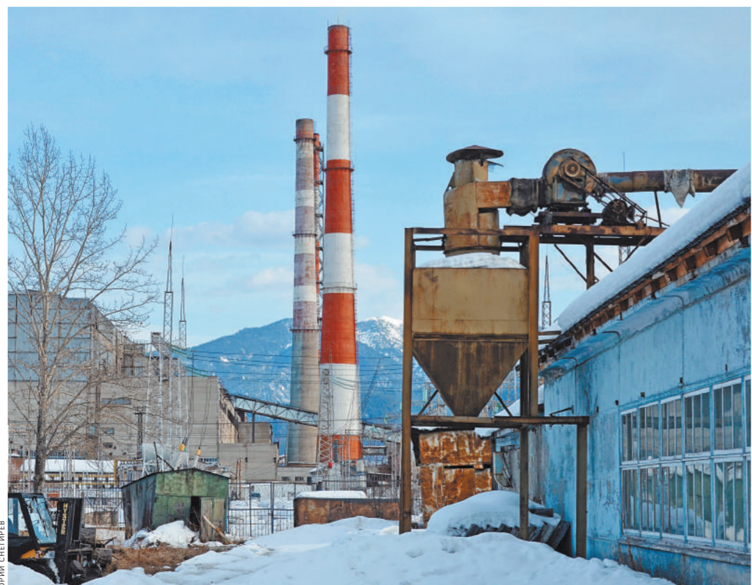
Байкальский ЦБК, который без малого 50 лет травил Байкал, закрыт. Работает только ТЭЦ, которая снабжает 13-тысячный город теплом и электроэнергией. На его месте могут построить гостиничный комплекс.
