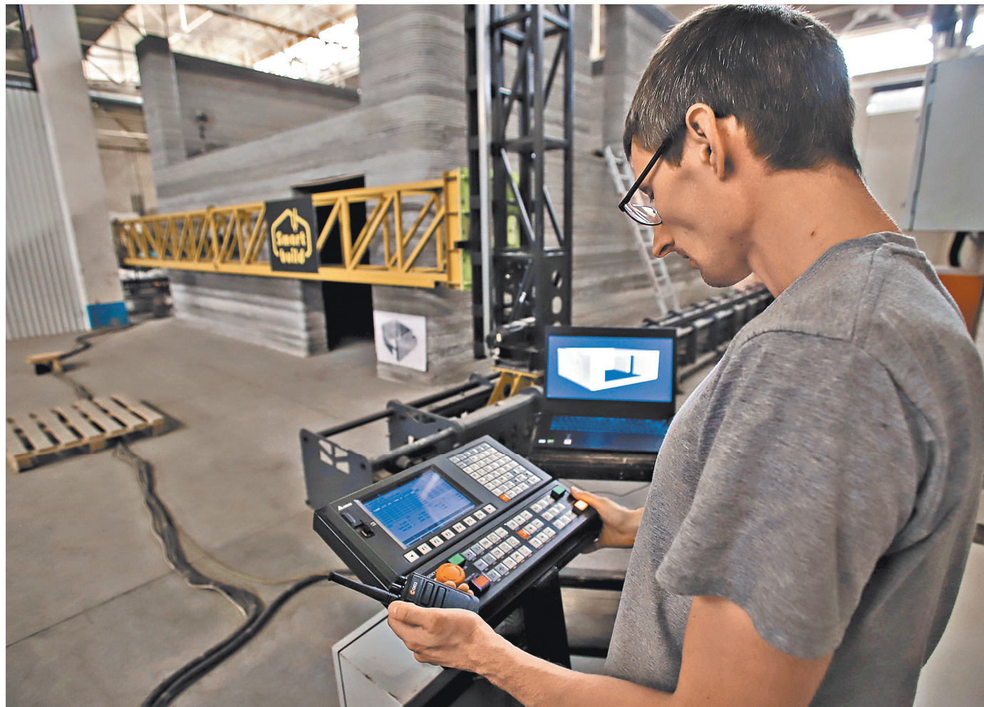
Для строительства нового здания нужны всего несколько специалистов.
