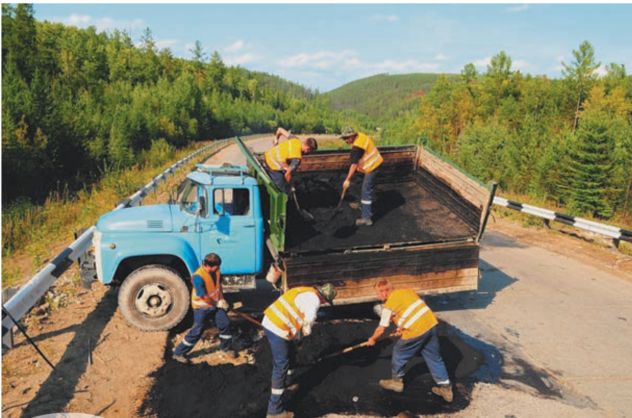
Студенты Сибирского федерального университета ремонтируют дорогу на БоГЭС.
