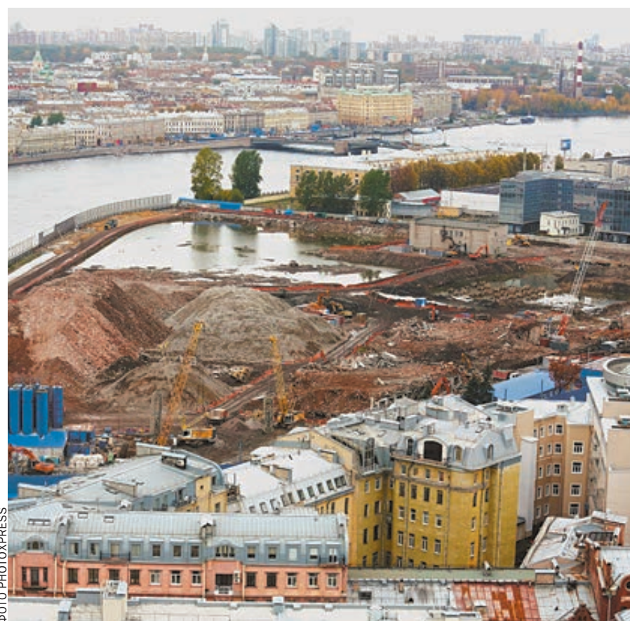
Строительство проекта «Набережная Европы», где планируется ВС и Арбитражный суд
