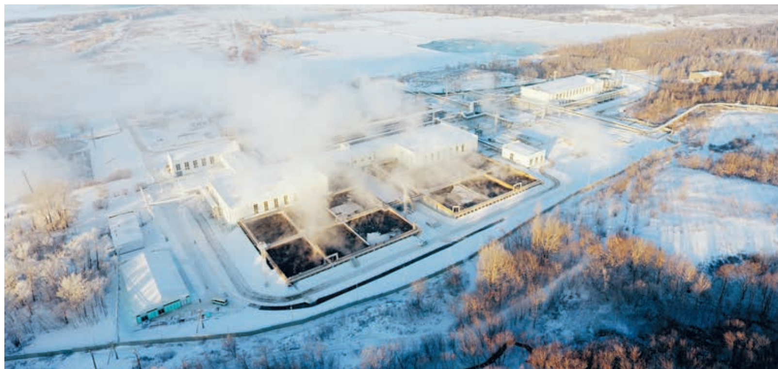
Комплекс биологических очистных сооружений «Башнефть – Уфанефтехим» отвечает самым строгим экологическим стандартам.
