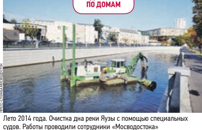
Лето 2014 года. Очистка дна реки Яузы с помощью специальных судов. Работы проводили сотрудники «Мосводостока»
