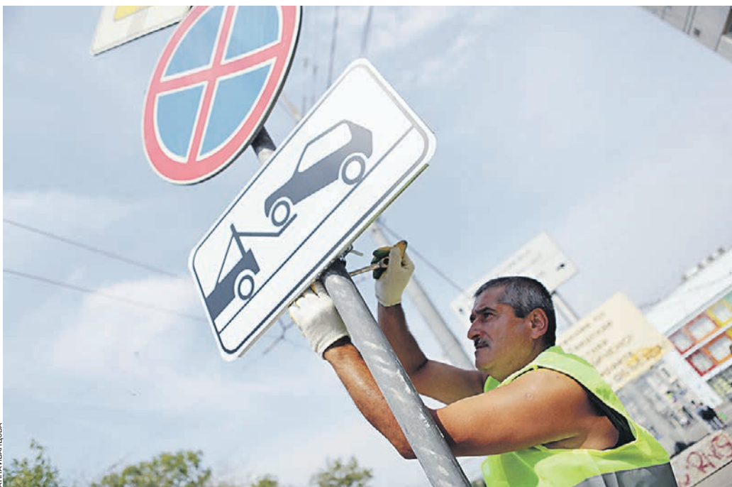
Вчера 13:21 Сотрудник Центра организации дорожного движения устанавливает первый знак «Работает эвакуатор» на улице Трехгорный Вал
