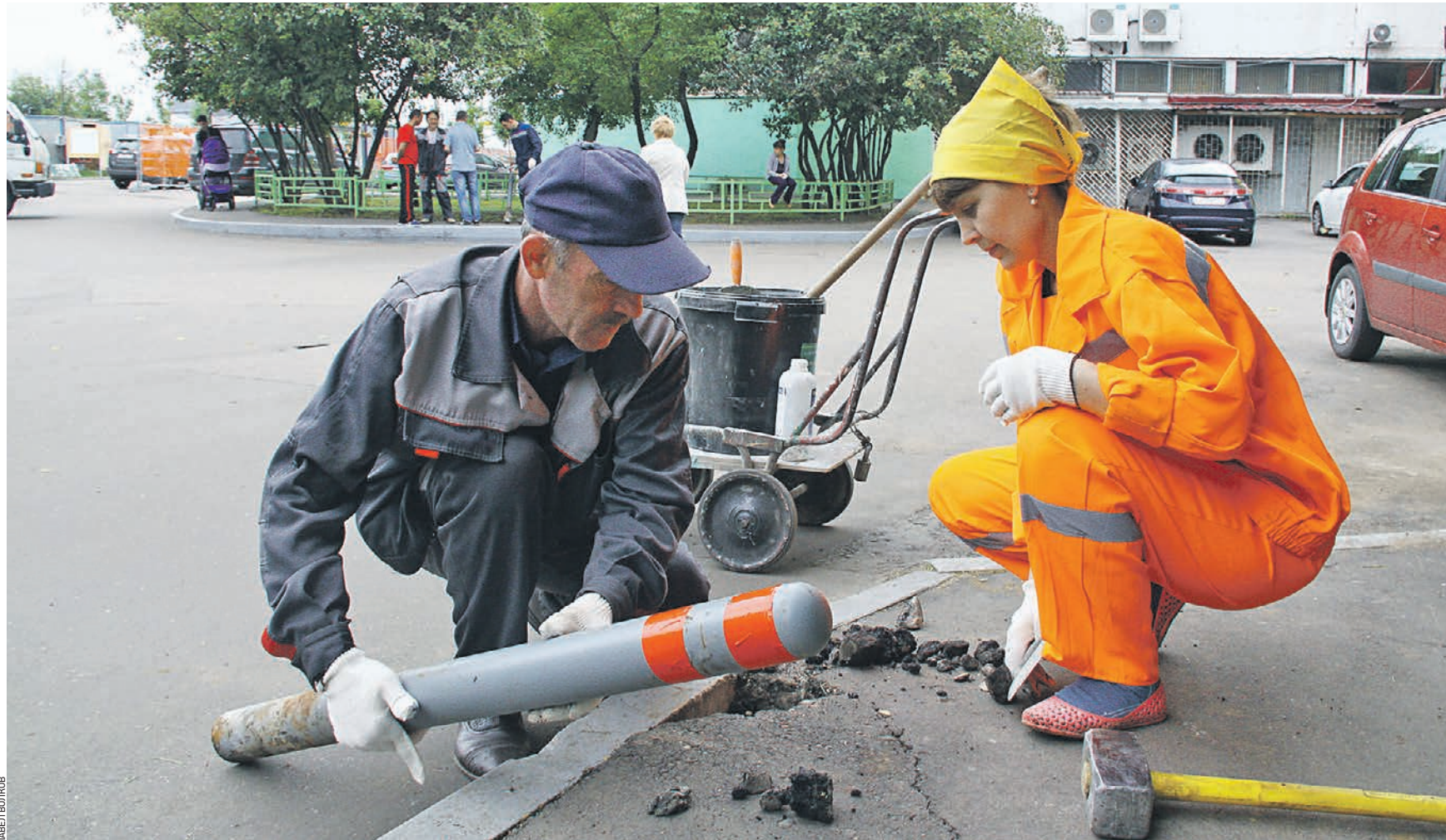
22 июля 14:27 Рабочий Юрий Тихлолаз вместе с коллегой Валентиной Бужор устанавливают новый противопарковочный столбик около дома № 140 на Каширском шоссе. Ранее ограждение повредил грузовик, подъезжавший к продуктовому магазину
