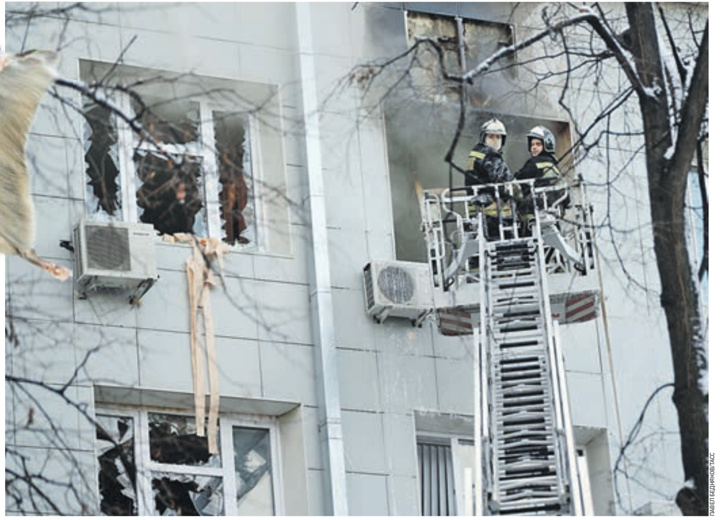
Вчера 10:30 улица Новослободская, 47. Спасатели в полной боевой выкладке продолжают бороться с пожаром в здании культурного центра МВД. Из-за того что пламя охватило верхние этажи здания, им пришлось использовать специальные лестницы
