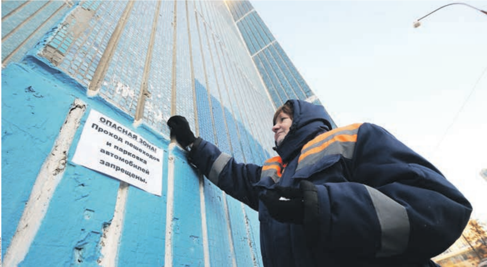
Вчера 15:00 Руководитель рабочей бригады Галина Ситникова подготавливает фронт работ. Сейчас здесь будут зачищать бетон на балконах, ну а пока территорию ограничили от прохожих
