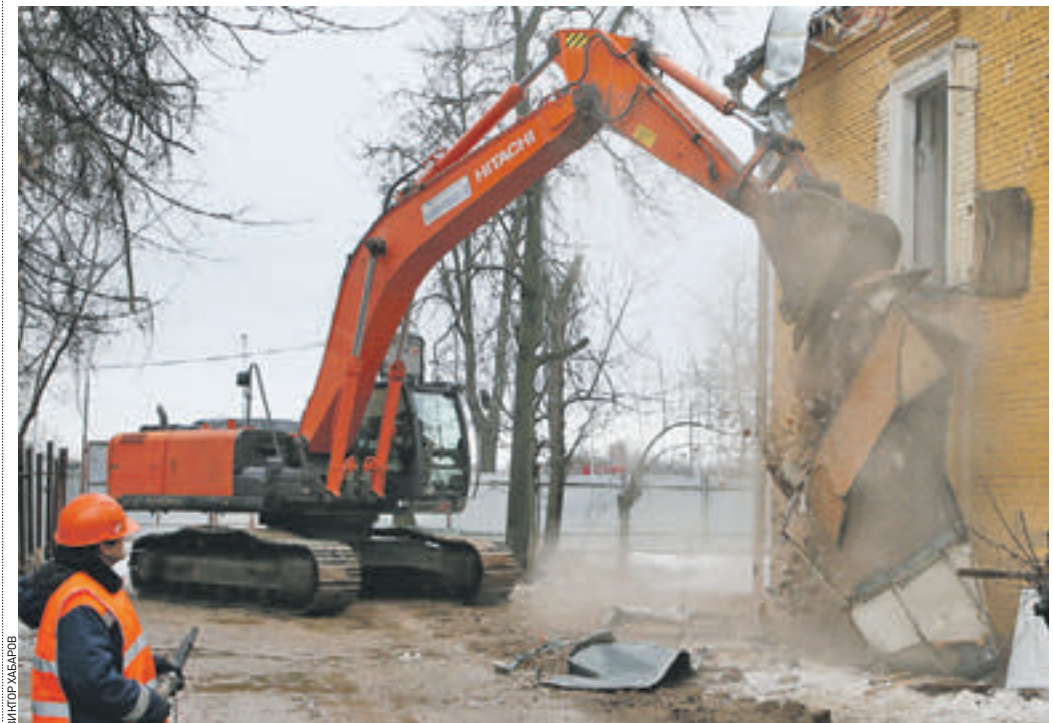
15 февраля 2016 года 08:06 Аварийный дом № 8 по улице Мостотреста в городском округе Щербинка начали сносить. Экскаватор уже сломал часть стены, ход работ контролирует рабочий Александр Орлов
