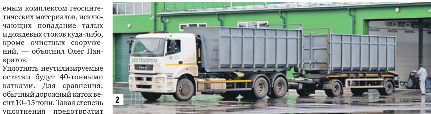
Вчера 14:19 Генеральный директор компании-инвестора, владеющей экотехнопарком в Калужской области, Андрей Чиркин показывает автоматическую систему по сортировке твердых бытовых отходов (1) Разгрузочная зона завода по переработке мусора (2)
