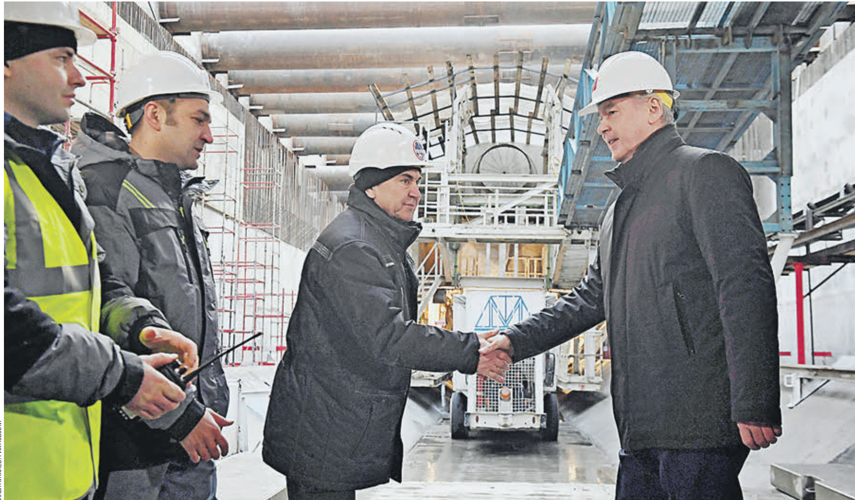
Вчера 13:12 Мэр Москвы Сергей Собянин (справа) благодарит главного инженера Алексея Чугунова (в центре) за работу на строительстве станции БКЛ «Текстильщики». Вместе с коллегами Иваном Тимофеевым и Константином Пономаренко (крайние слева) он участвовал в подготовке к запуску «Виктории»
