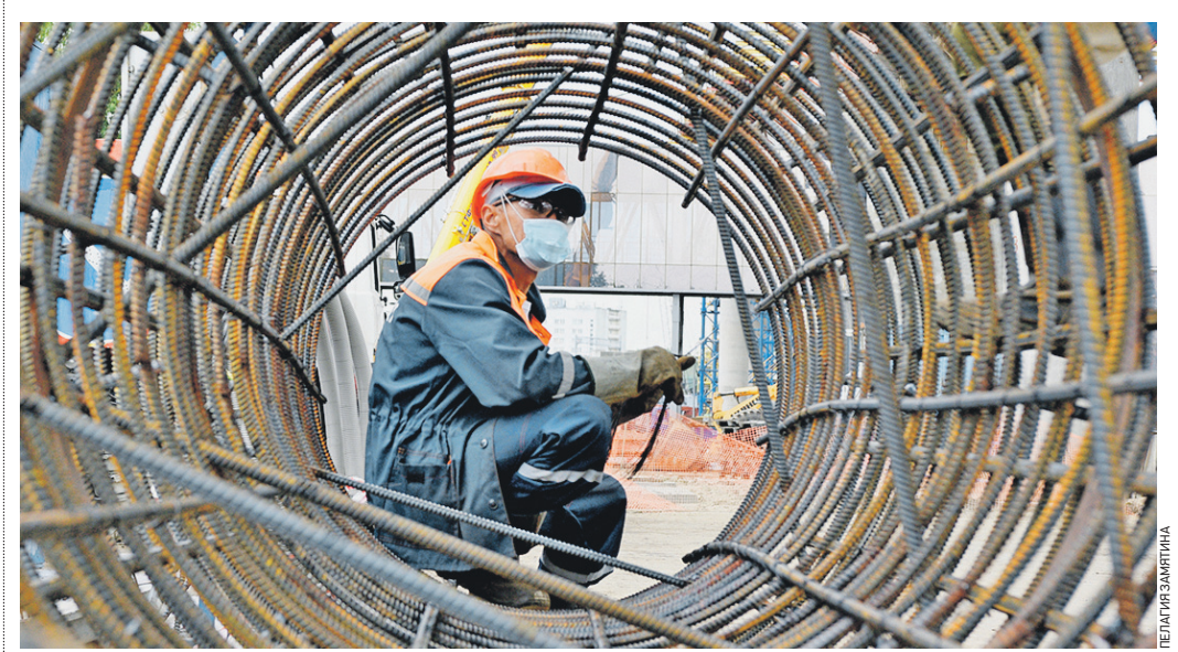
Вчера 12:03 Рабочий Роман Релин делает армирование каркаса конструкции на одном из объектов строительства Северо-Восточной хорды
