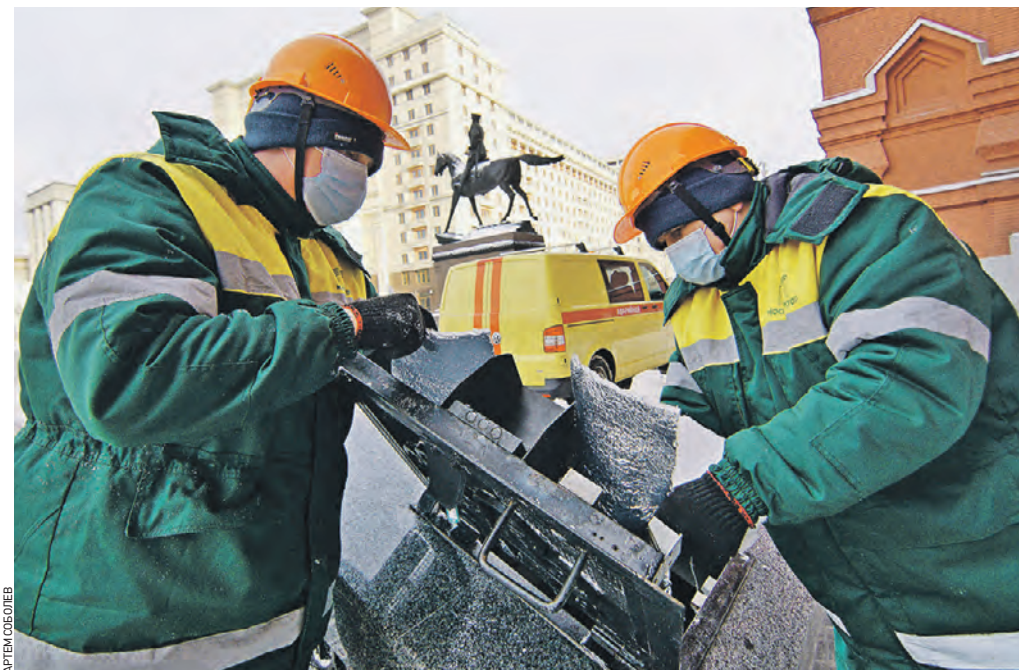
Вчера 10:34 Специалисты «Москоллектора» Борис Петров (слева) и Юрий Руднев утепляют вентиляционную шахту с помощью пенофола
