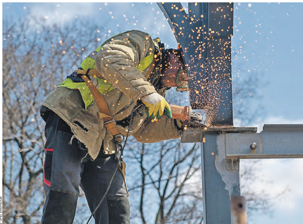
9 апреля 11:06 Рабочий Денис Мушкет проводит сварочные работы. Он крепит металлоконструкции для установки шумовых матов на станции «Каланчевская»
