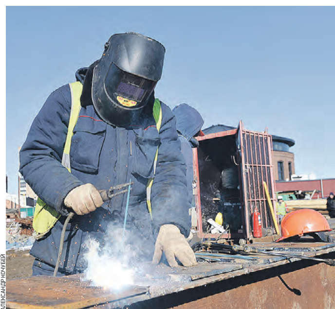
10 марта 2022 года. Сварщик Алексей Моршнева работает на стройке коттеджного поселка
