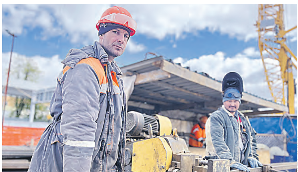
6 мая 2023 года. Арматурщик Федор Муравьев и сварщик Султан Байбусинов (справа) во время строительства станции «Аэропорт Внуково» Солнцевской линии метро
