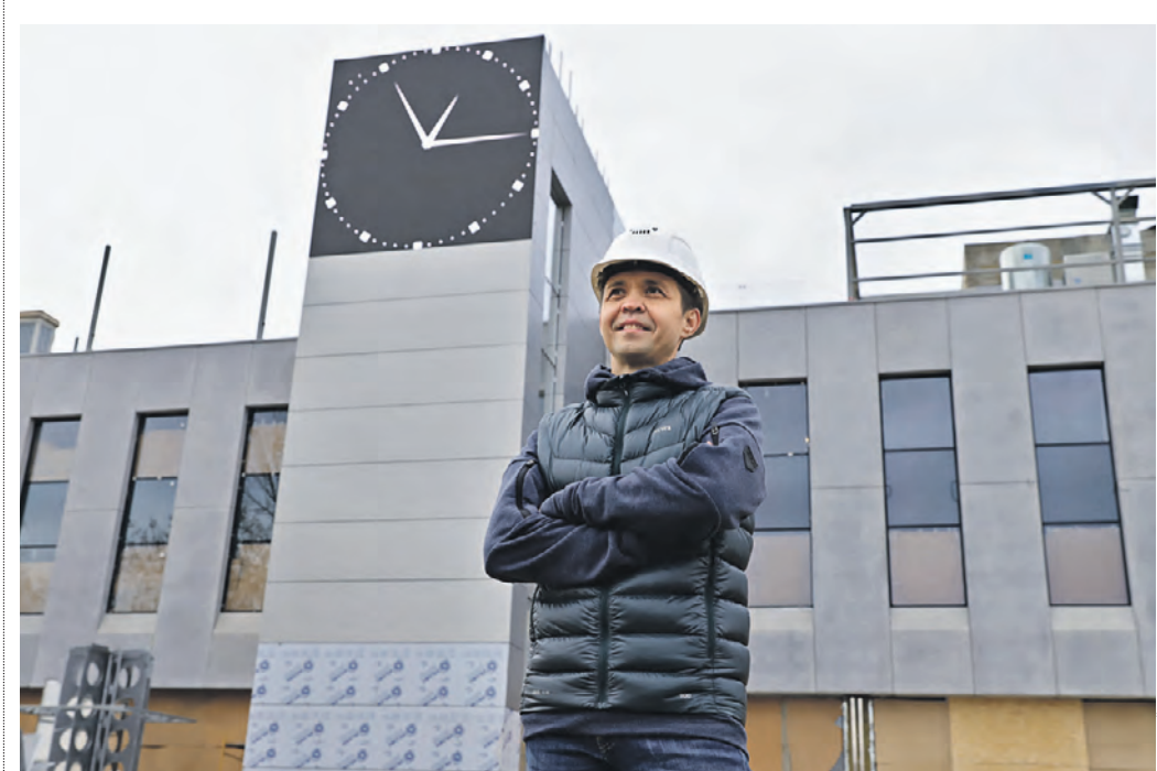
15 октября 2022 года. Руководитель проекта реконструкции Южного речного вокзала Максим Воинов показывает первые результаты преобразования территории
