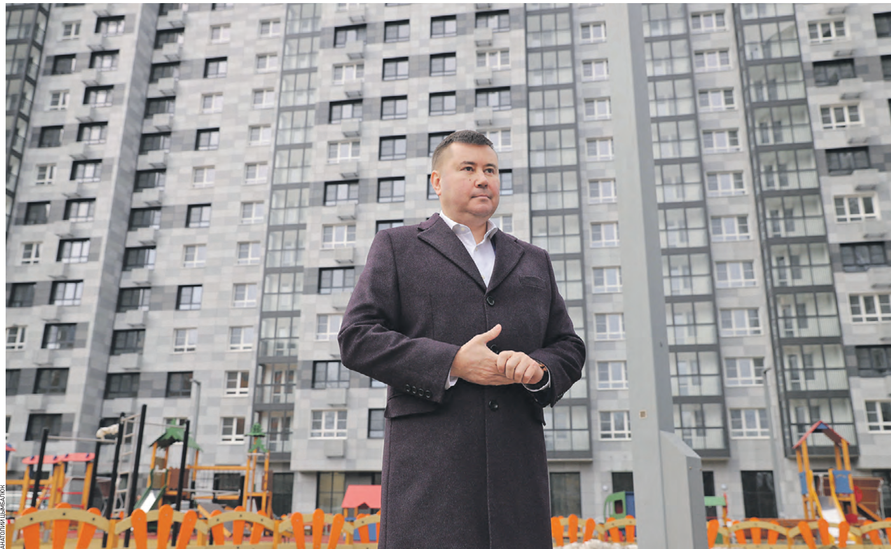
Вчера 14:37 Член Общественного штаба по контролю за реализацией программы реновации Сергей Ладочкин осматривает новостройку на Осташковской улице в Бабушкинском районе. Существенных недочетов не обнаружено
