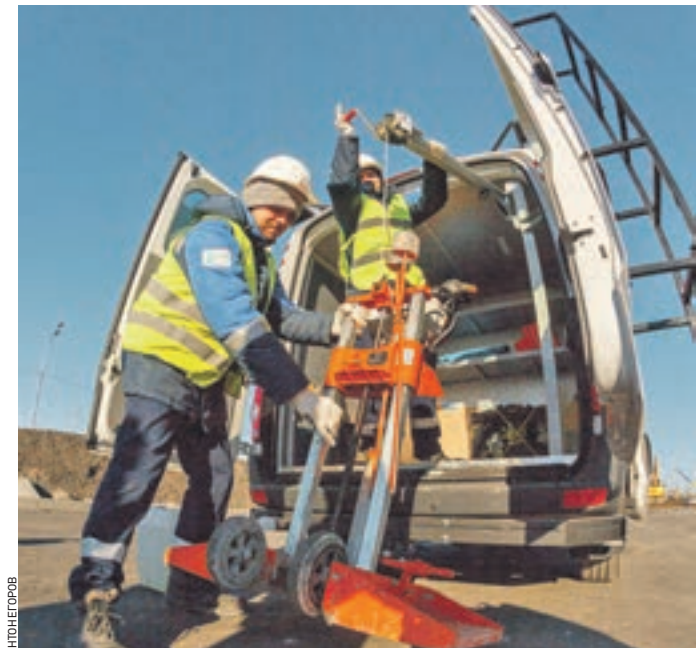
6 ноября 13:29 Инженеры Николай Сурков (на переднем плане) и Михаил Дурасов устанавливают бур, чтобы взять пробы асфальта
