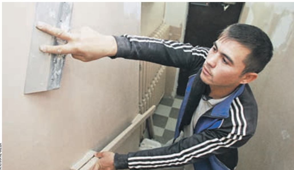
Вчера 15:45 Мастер-штукатур Валерий Ибрагимов выравнивает стены в подъезде дома № 23 в 3-м Самотечном переулке. В доме отремонтируют и внутридомовую систему электроснабжения
