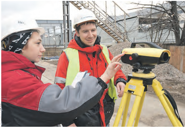
2 апреля 2015 года. Строительство станции метро «Технопарк»
