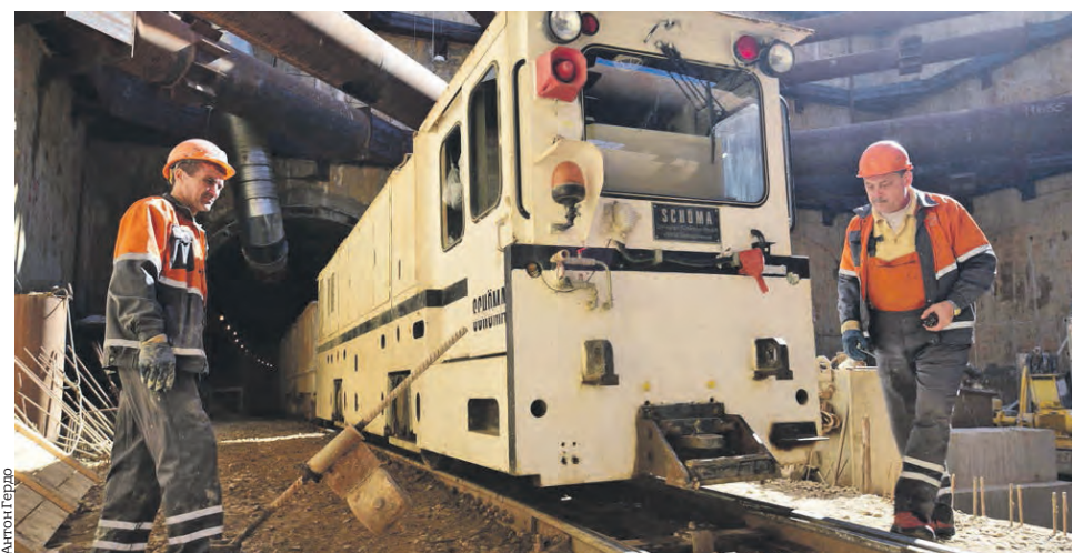
20 августа 2015 года. Строительство станции метро «Рассказовка»
