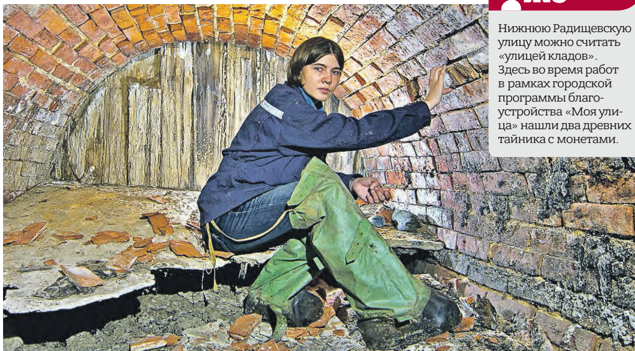
17 июня. Специалист ВООПИиК Елизавета Ненашева осматривает старинную кладку подземного канала
