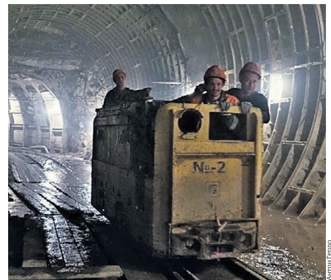
19 марта 2020 года. Рабочие у тоннелепроходческого щита «София» на стройке БКЛ
