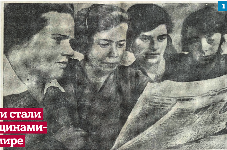
Ударницы Метрострой, комсомолки-значкистки, работающие на Кировской станции, АЛЕКСАНДРОВА, МАРЕНКОВА, БАРАН и УТЕВСКАЯ за чтением газеты.
