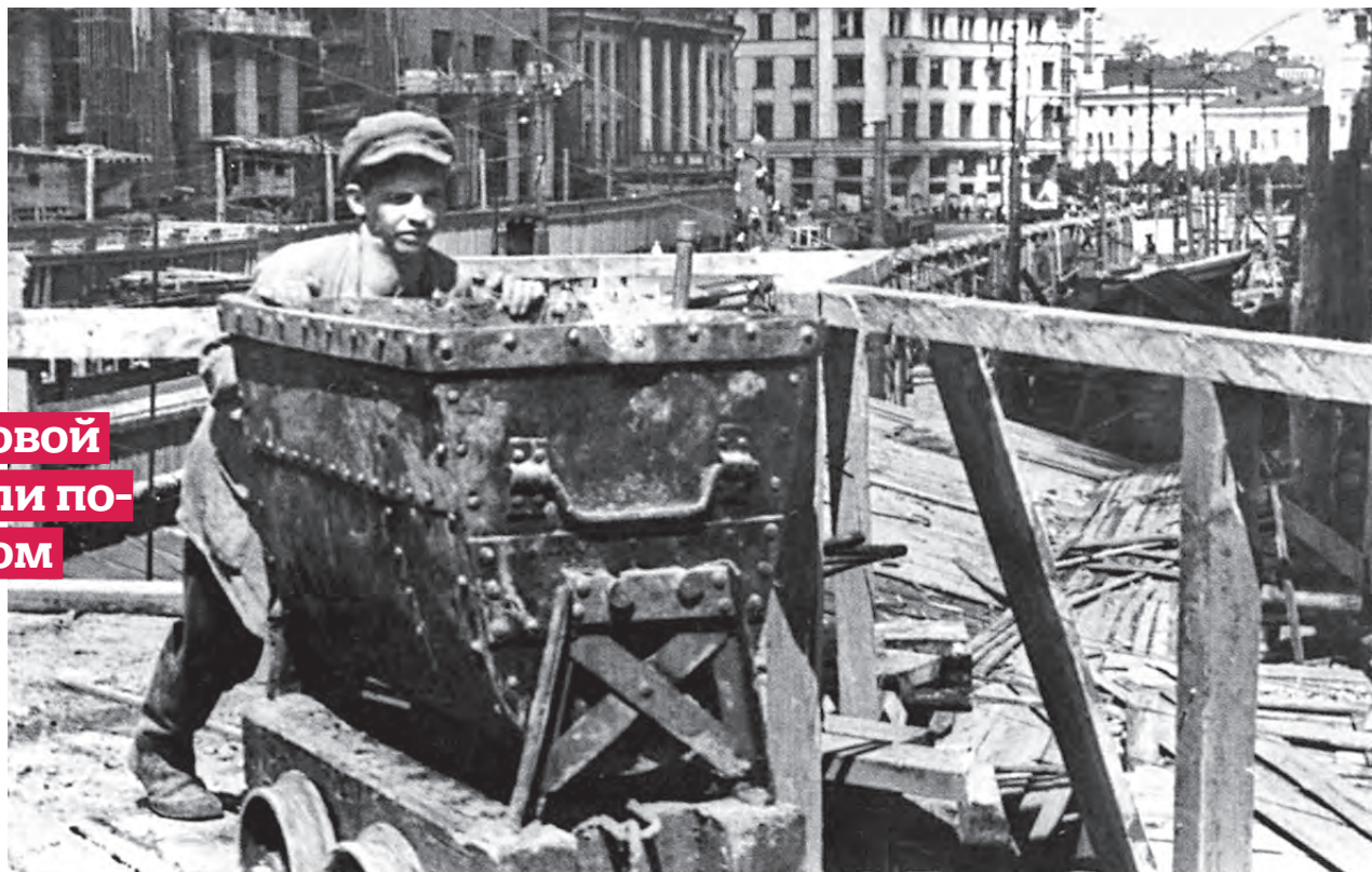
1934 год. Строитель метро работает с эстакадой для подъема грунта на поверхность у станции «Охотный Ряд»
